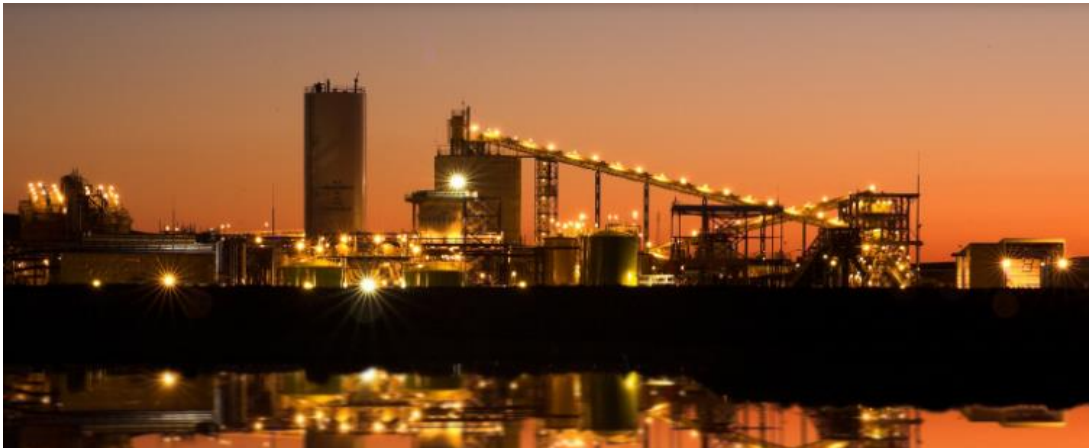
Las Cruces Plant
