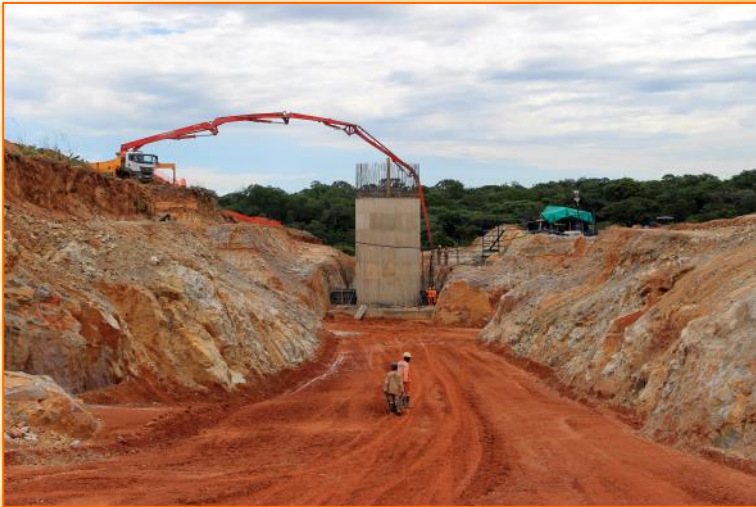
CHISOLA DAM INLET 20-JAN-2014
